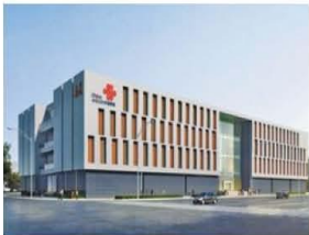
廊坊联通数据库项目
