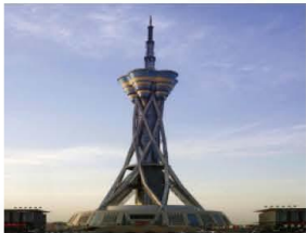
河南广电发射塔工程
